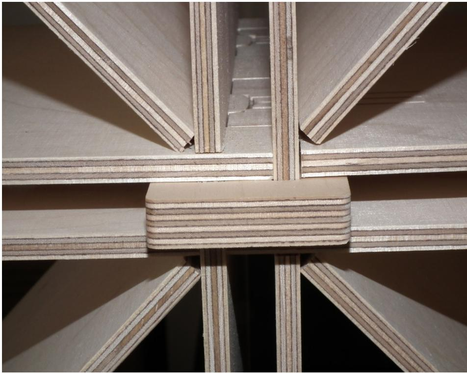
An der Seite werden zur Verbindung die Klammern mit einem Schlitz verwendet:
